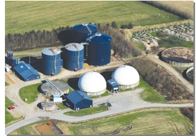
BLAABJERG BIOGAS PLANT (1995/96) BLAABJERG 沼气厂 (1995/96)
