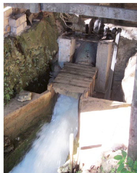
Microhidroeléctrica construida localmente en el estado Shan, Myanmar
