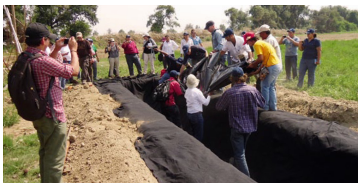
Instalación de un biodigestor tubular durante la conferencia anual de RedBioLAC en México
