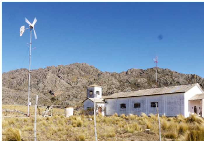
Una escuela en un área remota de Argentina: un emplazamiento de instalación típico para aerogeneradores pequeños
