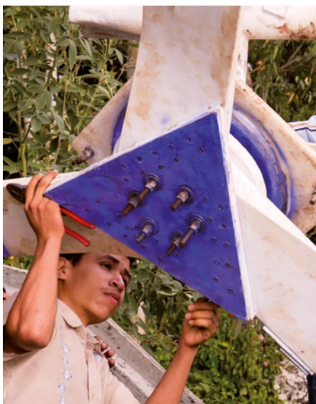
Instalación de un aerogenerador pequeño en Nicaragua
