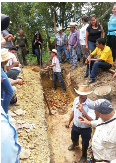
Preparación del emplazamiento para la instalación de un biodigestor tubular en Guadalupe, Santander
