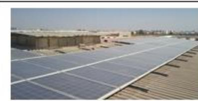
Installation industrielle dans le plan de toiture non optimal « intégration simplifiée » Perte 5% et 28% par an.
