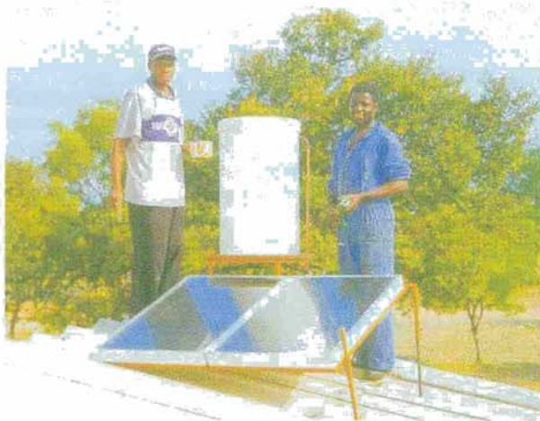
Foto 22 Sistema solar domestico para aquecimento de água
