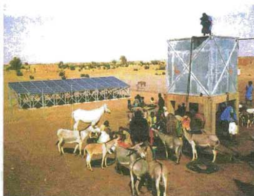
Foto 15 Bombeamento solar de água potável no noroeste da África
