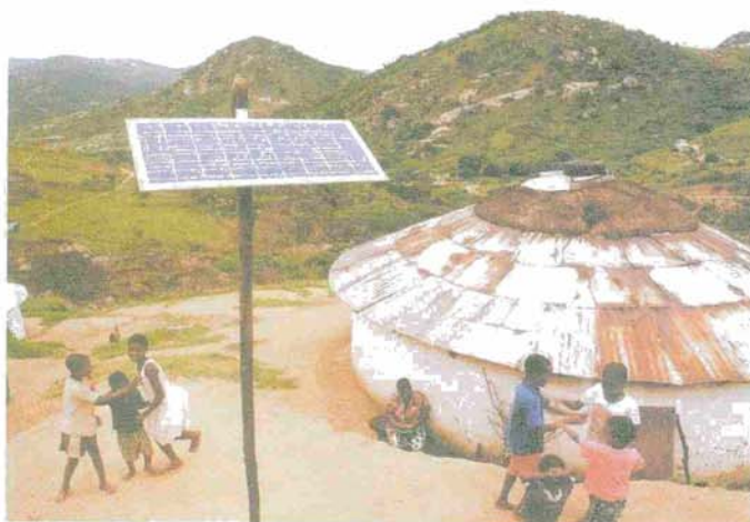
Foto 12 Sistema solar de casa individual de 50 Wp
