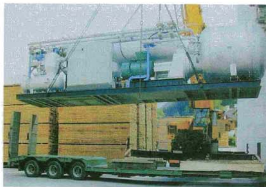
Foto 31 Turbina e gerador de 300 kW na Áustria
