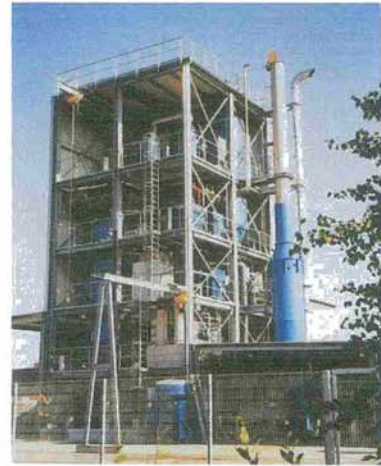
Foto 33 Gaseificador de biomassa com turbina dupla de 1MW
