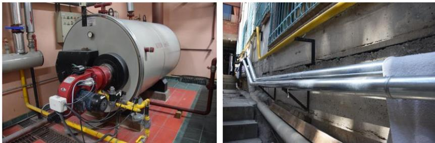
Las medidas de Eficiencia Energética implementadas estaban relacionadas con: el cambio de luminarias convencionales por luminarias LED, gestionar el sistema de iluminación; mejoras en el sistema de climatización, a través de un cambio de la caldera que genera agua caliente y la optimización del sistema de distribución de agua caliente y; el diseño e implementación de un sistema fotovoltaico.
