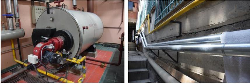
Die durchgeführten Energieeffizienzmaßnahmen bezogen sich auf: Wechsel von konventionellen Lichtquellen zu LED-Leuchten; die Verwaltung des Beleuchtungssystems; Optimierungen des Warmwasserverteilungssystems und der Klimaanlage durch Ersetzung des Warmwasserboilers; Auslegung und Inbetriebnahme einer Photovoltaikanlage.
