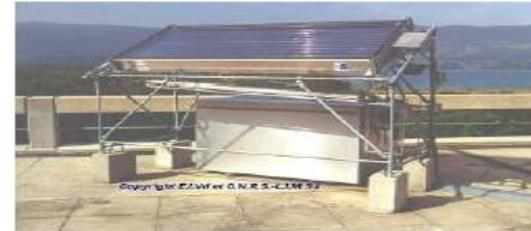
Solaire thermique conventionnel couplé à une machine à sorption (production de froid à partir de chaleur)
