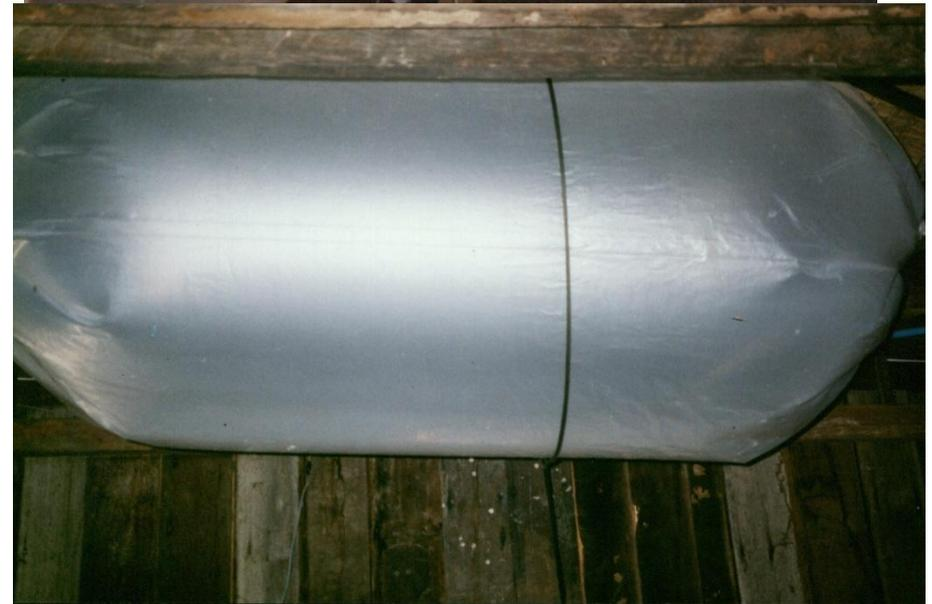
**Reservorios para biogas hechos en una capa de plástico**
