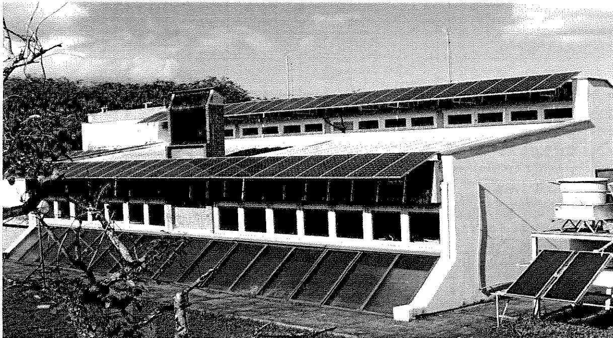
Figura 67: Representa uma central fotovoltaica (fonte:WWW.fsolar.co
