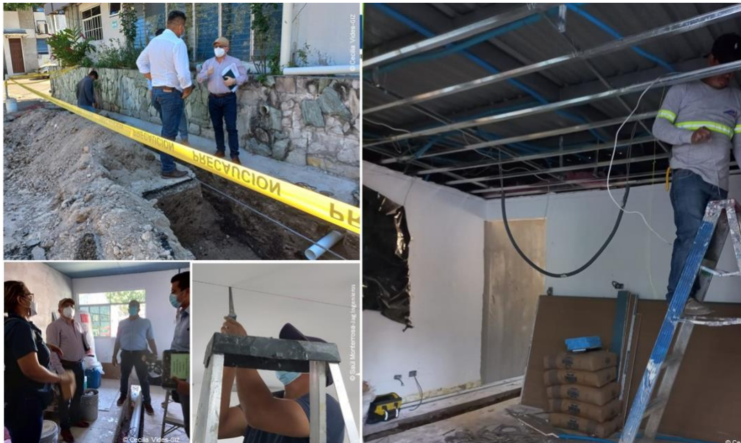
Foto: Construcción del nuevo laboratorio del Centro Regional de Semillas Forestales. Archivo GIZ.
