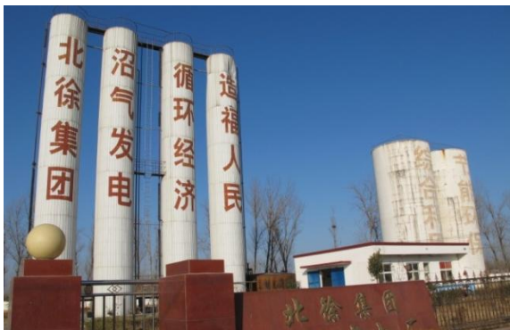
UASB-Fermenter an der Beixu Schweinefarm in Henan
