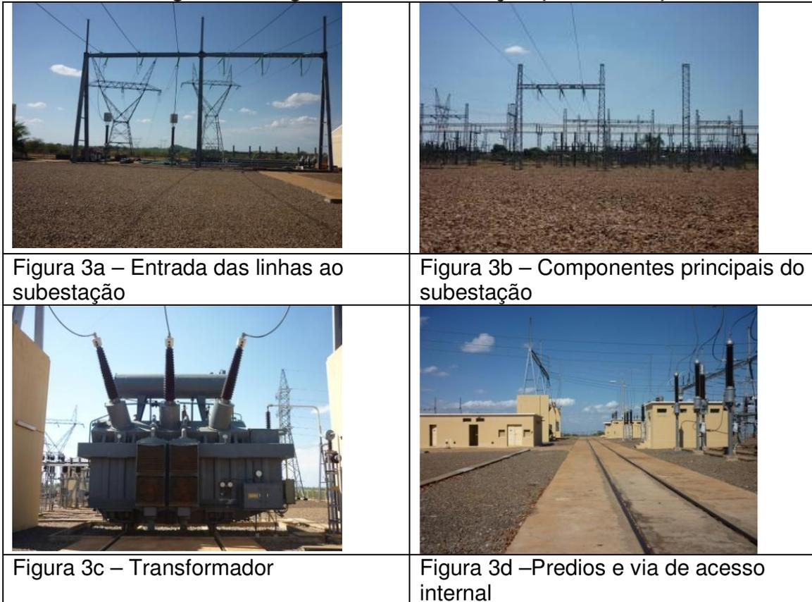
As imagens nas Figuras 1, 2 e 3 mostram exemplos dos elementos centrais do projecto: as linhas, torres (nomes alternativos são: pilões, pilares), o transformador e outras infra-estruturas numa subestação. Decisões sobre o desenho das torres dependem principalmente da capacidade energética exigida e os custos, onde entram os materiais e o tamanho da faixa que deve ser mantida limpa.
