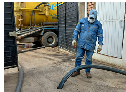
Foto: Limpieza del pozo séptico. Archivo GIZ/ PERIAGUA.
