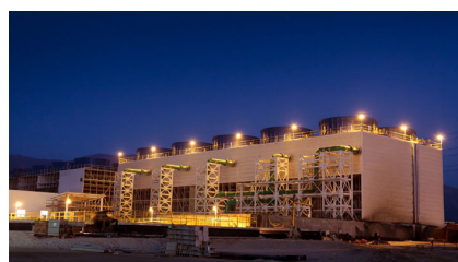
Foto: Central Termoeléctrica Angamos, Chile. Archivo AES Andes.
