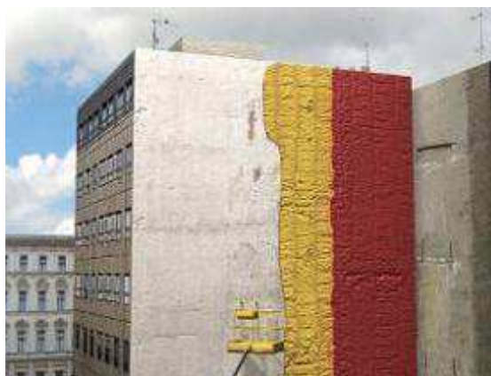
Figure 33 : isolation extérieure par PUR projeté ( http://www.maroc.prix-construction.info )
