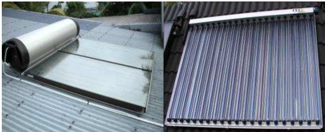
Figure 8 : Capteurs à plan vitrés et capteurs sous vide
