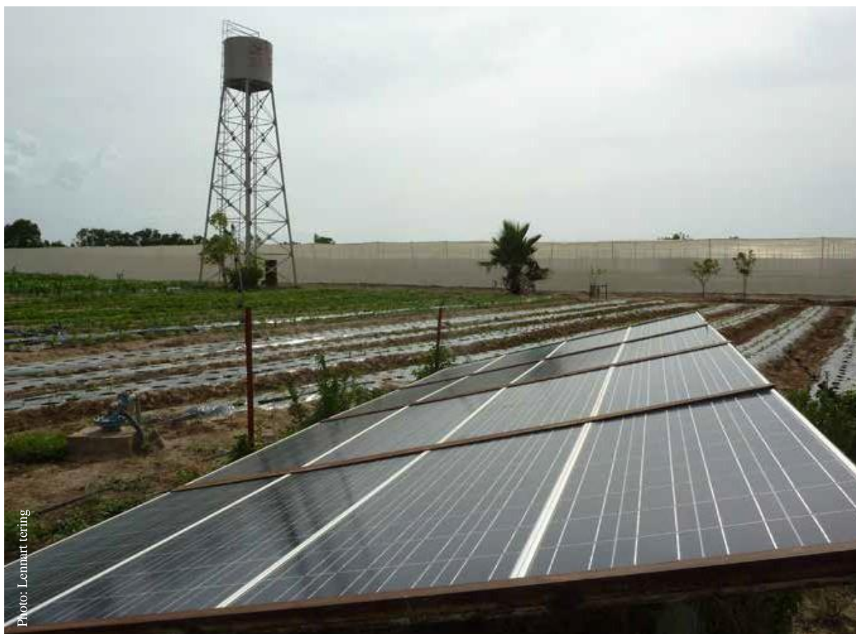
SPIS équipé d'un réservoir surélevé utilisé pour l'irrigation à l'intérieur et à l'extérieur d'une serre
