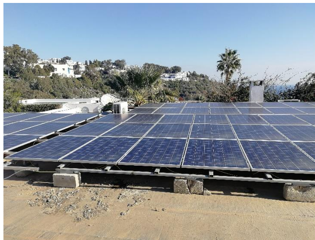
Figure 66: installation à l'horizontale suite à la demande du client : 15% de perte de production
