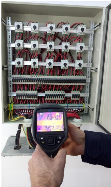
Figure 10: Utilisation de la caméra thermique pour vérifier la température au niveau des coffrets
