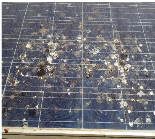
Figure 37: encrassement des modules lié aux excréments des oiseaux
