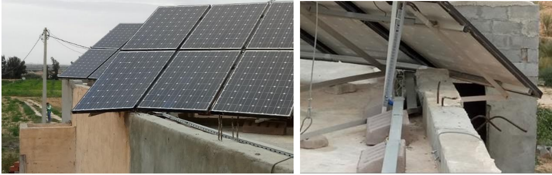
Figure 14: absence d'appuie extérieur
