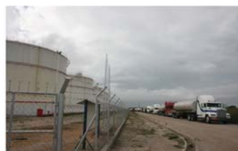
Armazenagem e Distribuição de Combustíveis
